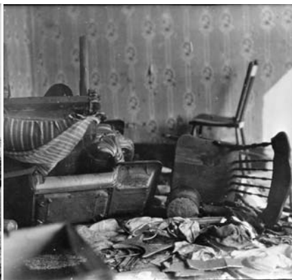
Unutrašnjost uništene kuće
